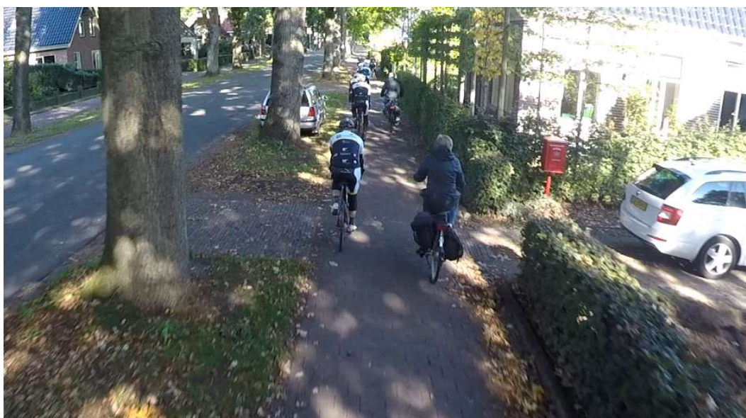
Het fietspad op routedeel 7 wordt negatief beoordeeld vanwege de beperkte breedte, tegelverharding en vele uitritten
