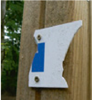
Dit dunne plastic bordje dat over de paal heen stak en met slechts twee schroeven is vastgezet breekt eenvoudig af.
